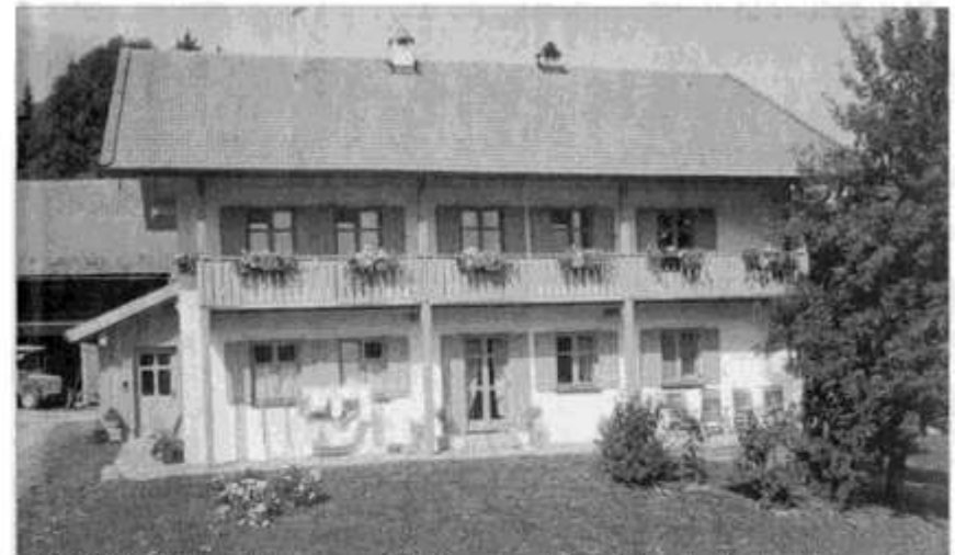
NACHHER: Die Holzverschalung ist weg, der Wohnraum durch das Auflassen der Balkonnische erweitert.
